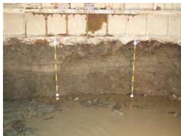
立坑壁面状況
