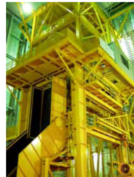
→ 檣全景 (主立坑)
